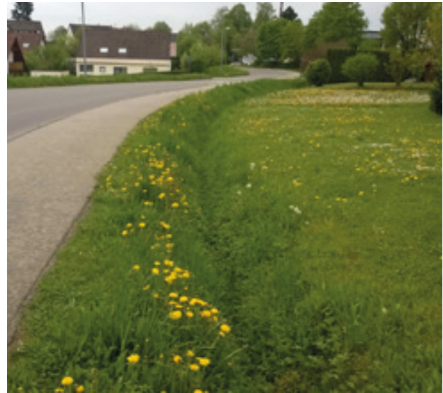
Abb. 4.8: Gleiches gilt für Entwässerungsgräben.
