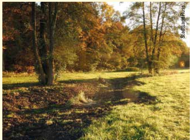
Herbstaspekt des neugestalteten Laufs des Klingengrabens (November 2016). Der Gewässerquerschnitt ist etwas 4–5 mal größer als zuvor und das Ufer ist deutlich abgeflacht.
