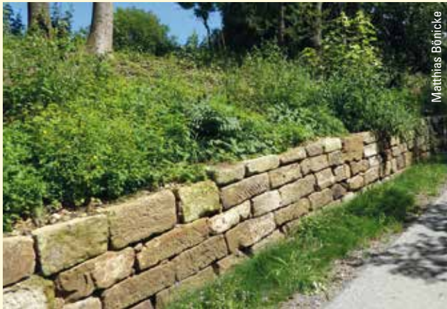
Sanierte Trockenmauer
