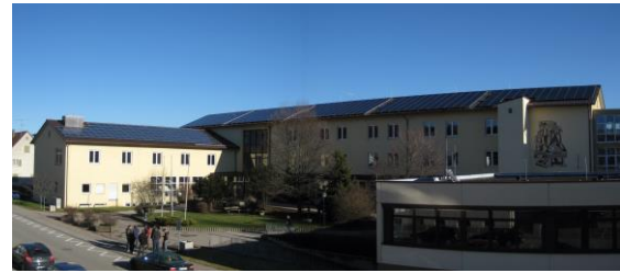
Gewerbliche Schule kurz vor der Generalsanierung
