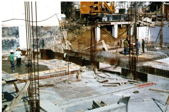
Hauptgebäude während der Bauphase im Jahr 1956
