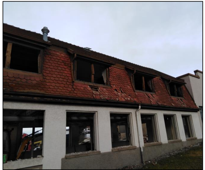
Länger leerstehende / ungenutzte Gebäude
